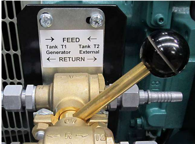
Фиг.31. Трёхходовой кран переключения источника топливоподачи (опция)
